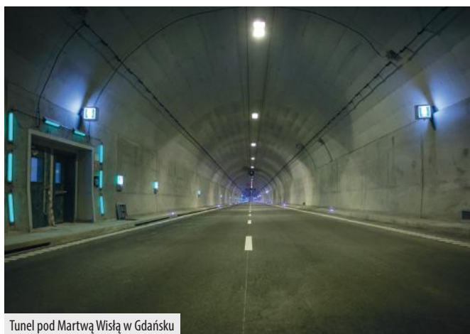
Tunel pod Martwą Wisłą w Gdańsku
