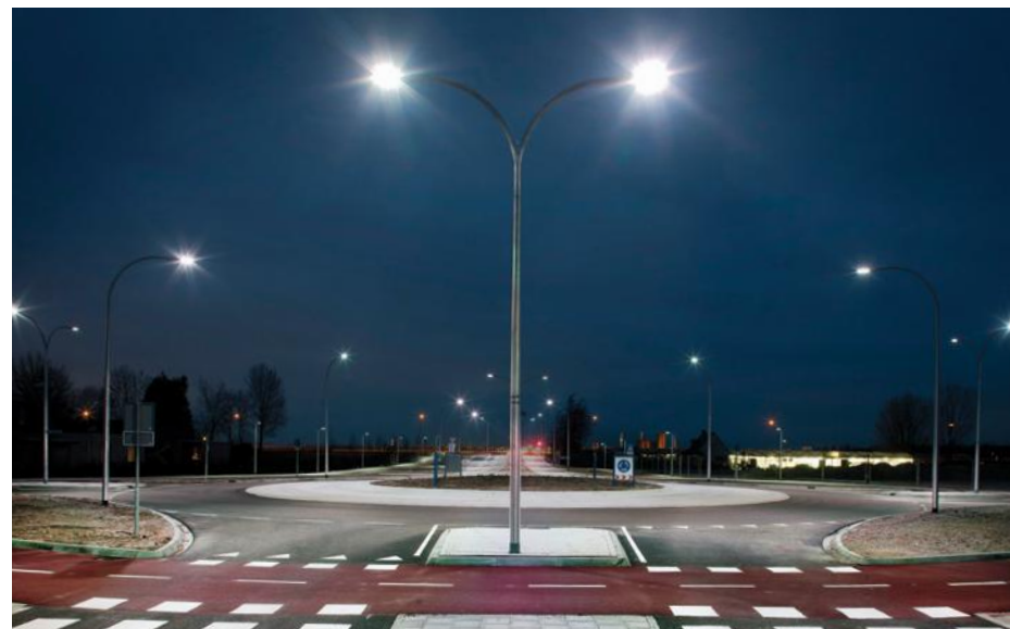
Przykładowe zastosowanie oprawy MA 20 MLED
